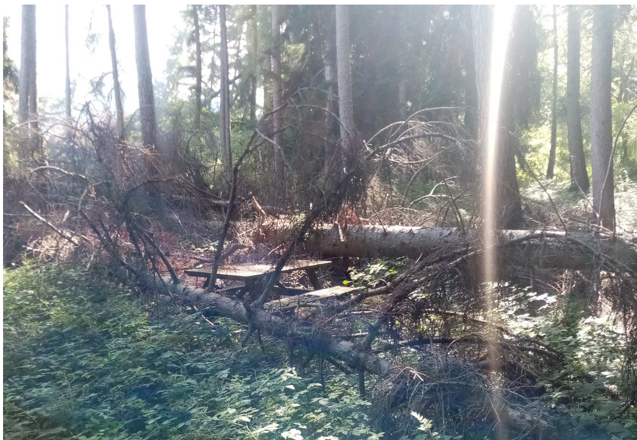
BERZO DEMO: strutture di servizio del Percorso della Memoria superstiti ai danni da incendio (P. forestale n. 26; 2022)
